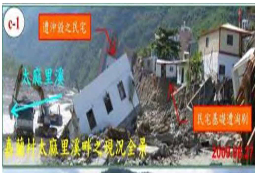
圖 1-3 莫拉克颱風民宅基礎遭淘刷
